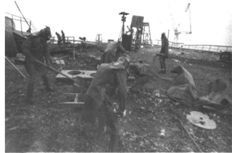
Από τις διαδικασίες καθαρισμού του χώρου που πραγματοποιήθηκε το ατύχημα.
